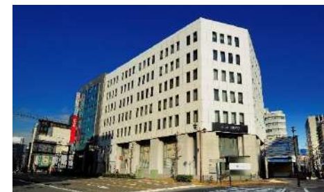
リスト関内ビル（横浜市中区）
